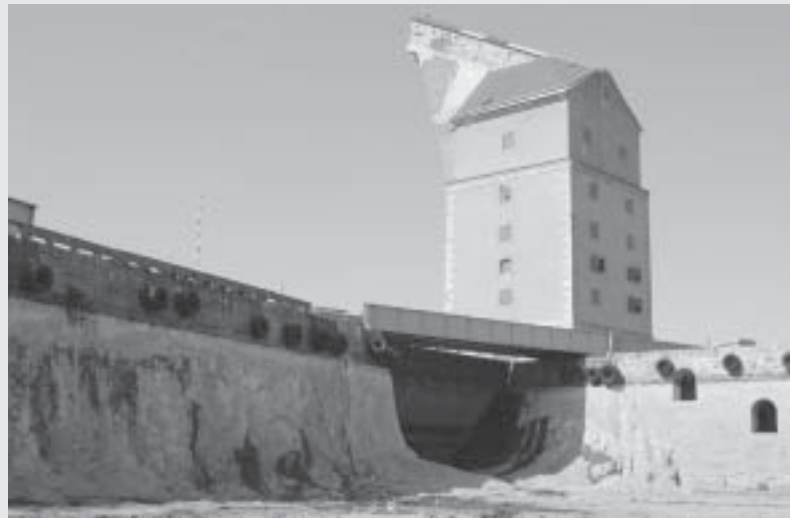
Gamla mastkranen och del av Inre svajningsrummet. Foto Christer Karlsson
