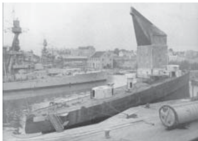
Yttre svajningsrummet och Gamla mastkranen 1939. I förgrunden ett av Sverigeskeppen och jagare under byggnad (troligen Karlskrona). Arkivbild
