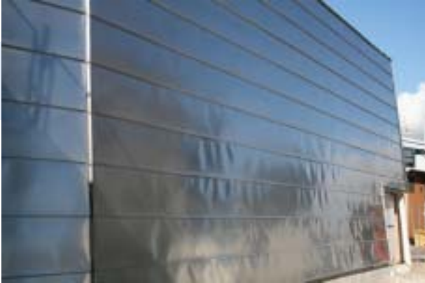
Vägg med specialtillverkad rostfri plåt
