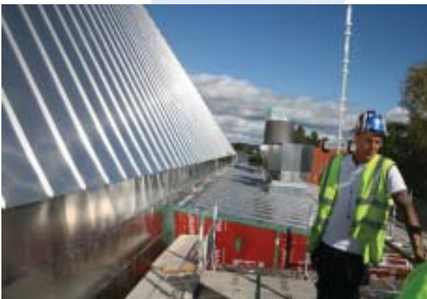
Plåtslagarmästare Johan Hansson ansvarar för plåtarbetena
